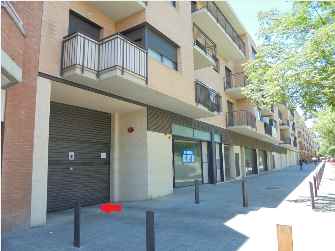
Vista de l'edifici en el qual s'ubica l'immoble i de l'accés al pàrquing
